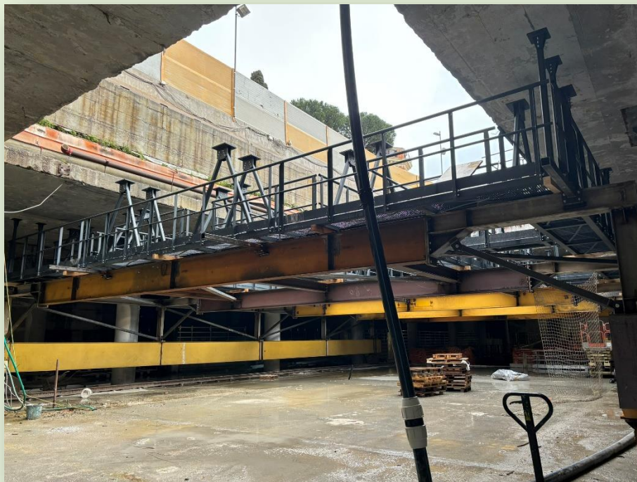
CANTIERE STAZIONE COLOSSEO (FORI IMPERIALI)
