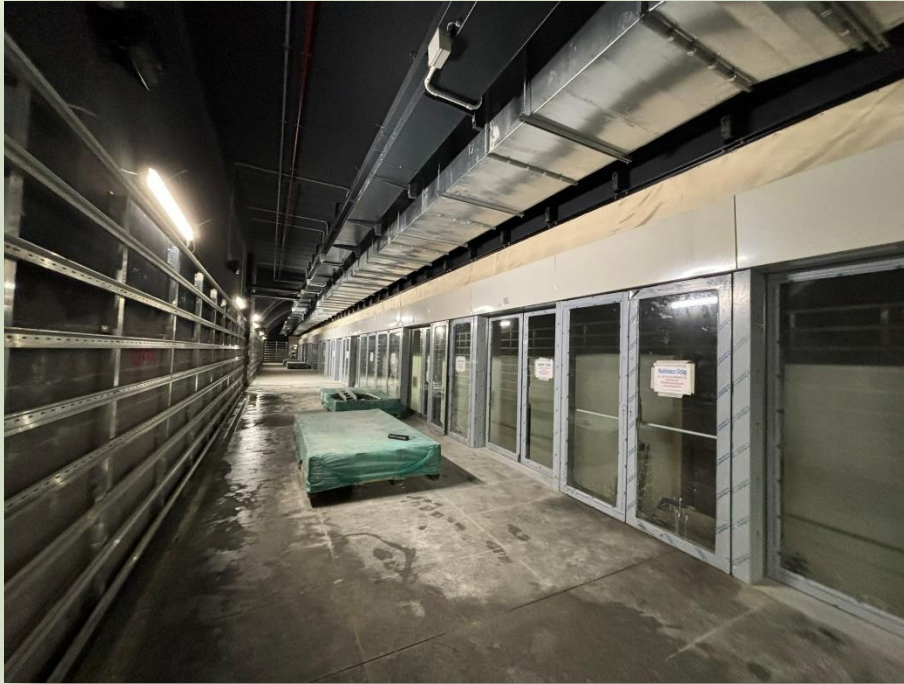
CANTIERE STAZIONE COLOSSEO (FORI IMPERIALI)
