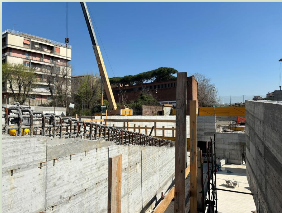
CANTIERE STAZIONE PORTA METRONIA
