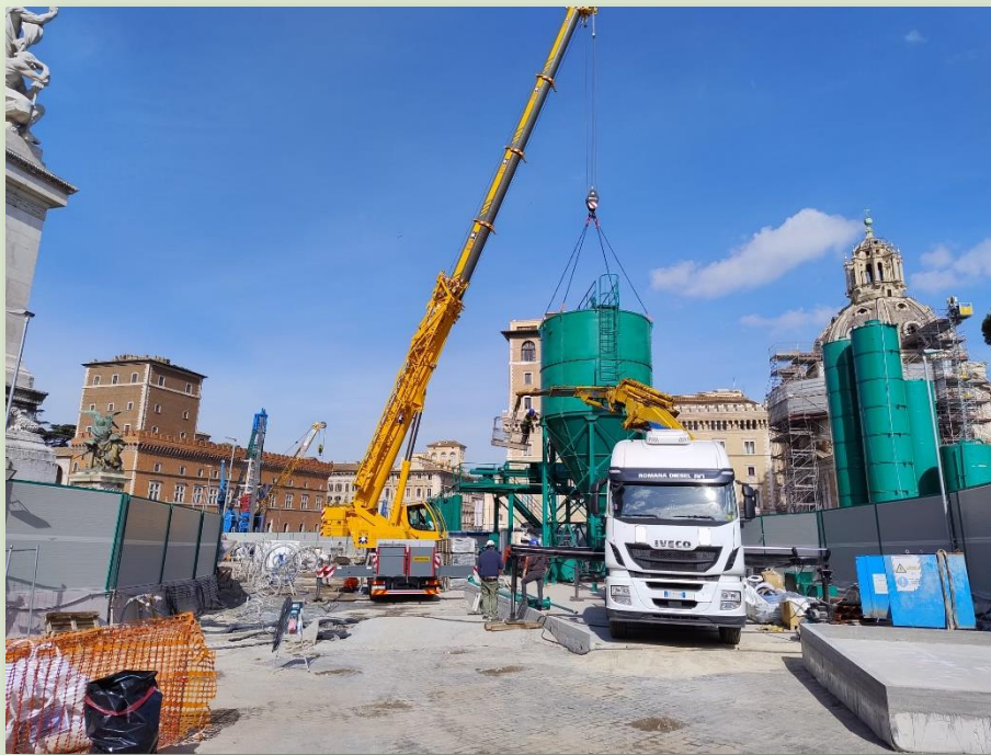
CANTIERE STAZIONE VENEZIA
