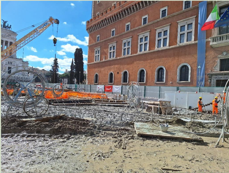
CANTIERE STAZIONE VENEZIA
