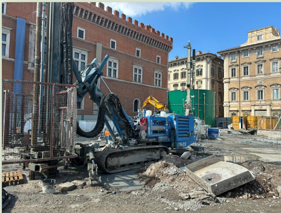
CANTIERE STAZIONE VENEZIA
